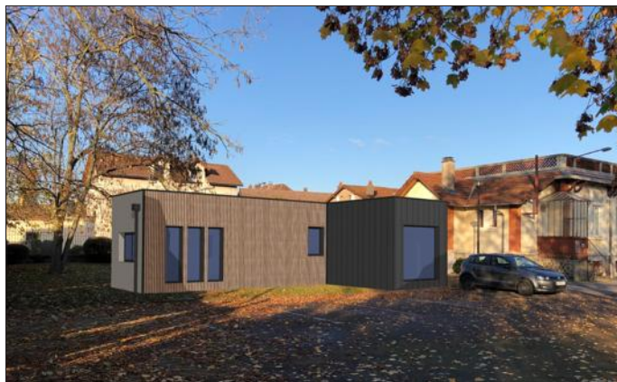
La première réalisation de la société La Fabric avec des containers maritimes sera un ensemble de bureaux implanté à Golbey. Photo VM/DR
